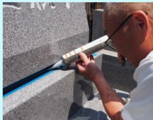
耐震ボンドによる目地施工の様子
